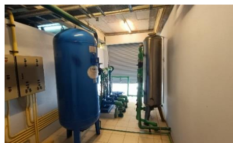
ภาพที่ 20 ระบบถังกรองน้ำใช้
