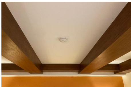
ภาพที่ 49 เครื่องดับจับควันในห้องพัก
