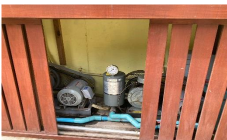
ภาพที่ 19 เครื่องเติมอากาศบ่อบำบัดน้ำเสีย
